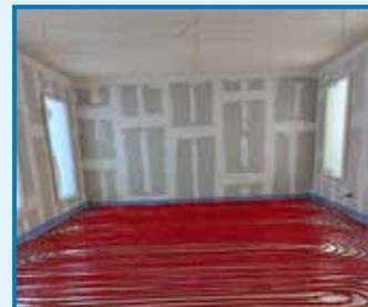
Fotos: Der Durchbruch erfolgt, Installation der Fußbodenheizung
